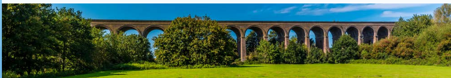
Chappel viaduct, nr Colchester
