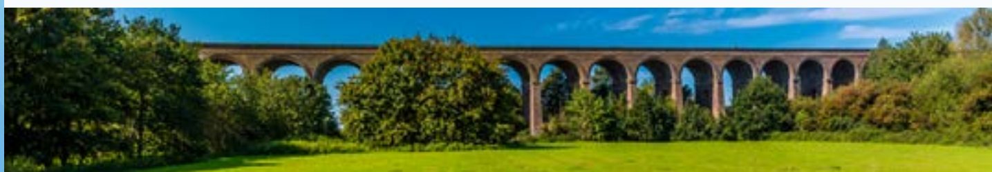
Chappel viaduct, nr Colchester
