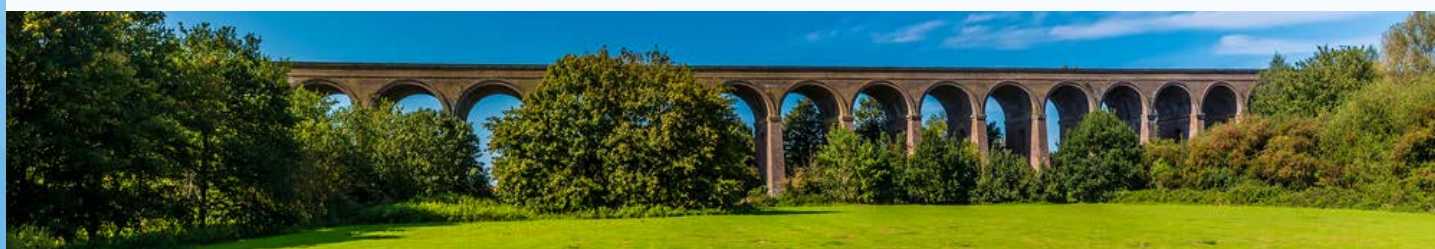
Chappel viaduct, nr Colchester
